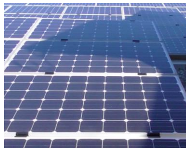
図 2.3. PV パネル上に発生する部分影
